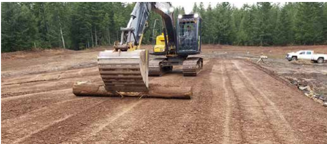
Excavator smoothing the surface. / Une excavatrice travaille soigneusement sur la surface.
