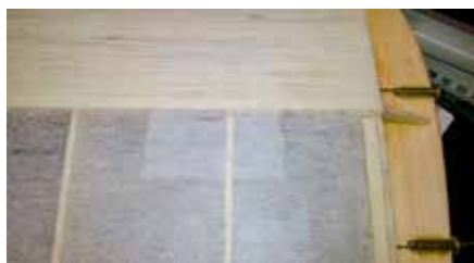
"Hangar Rash" shop punctures are a snap to patch at this stage. / Les perforations typiques du maniement (le proverbial Hangar Rash) sont aisément réparées. Photo by Paul Gibeault
