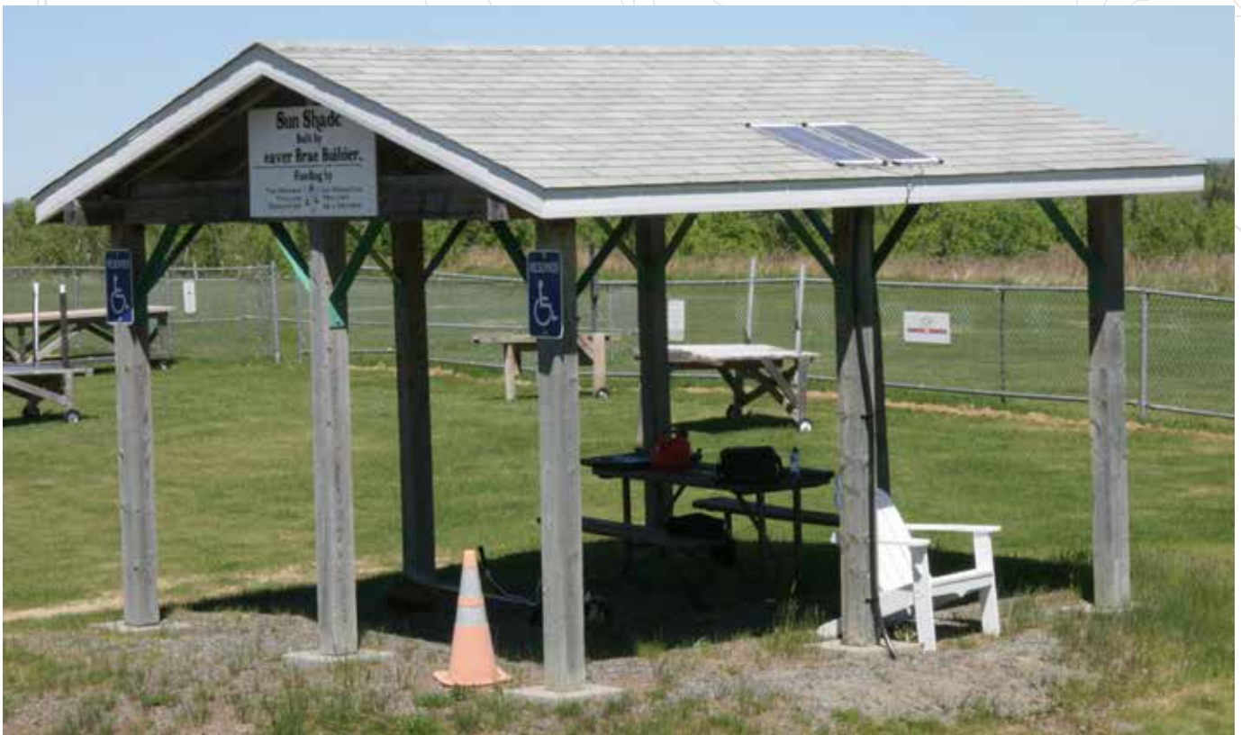
A pair of solar panels sit on the on a Sunshade Roof. / Une paire de panneaux solaires sur un toit d'auvent.
