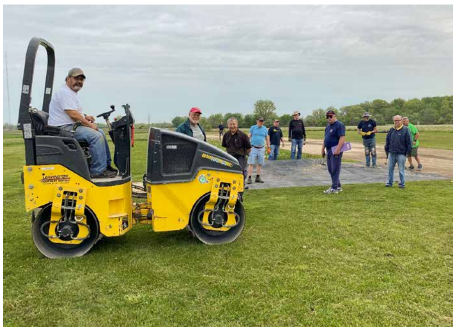
Paul Sousa from the Sun Parlor RC Flyers is keeping a close eye on the new Geotex runway construction. / Paul Sousa, des Sun Parlor RC Flyers, surveille les travaux d'installation de Geotex sur la piste.
